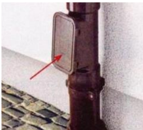
Slika 7 Revizija vertikalnog oluka
