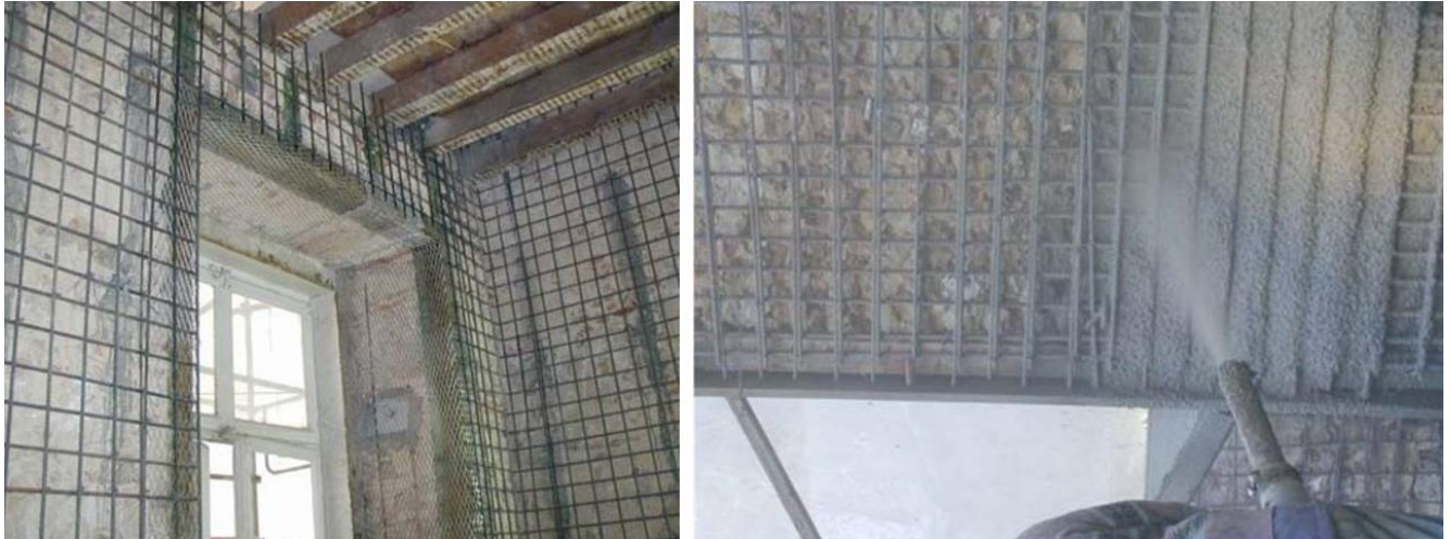
Slika 1 Primjer postavljene armature prije torkretiranja zida
