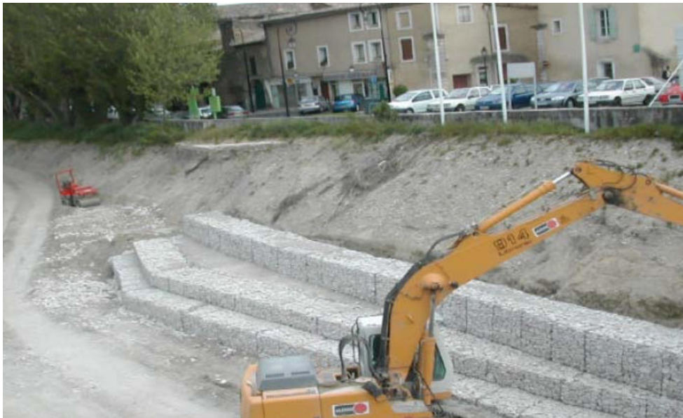
Slika 5.2 Prikaz gradnje sa gabionskim elementima
