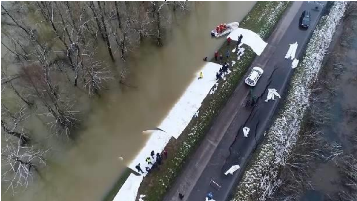
Slika 21. Sanacija nasipa kod Jasenovca
