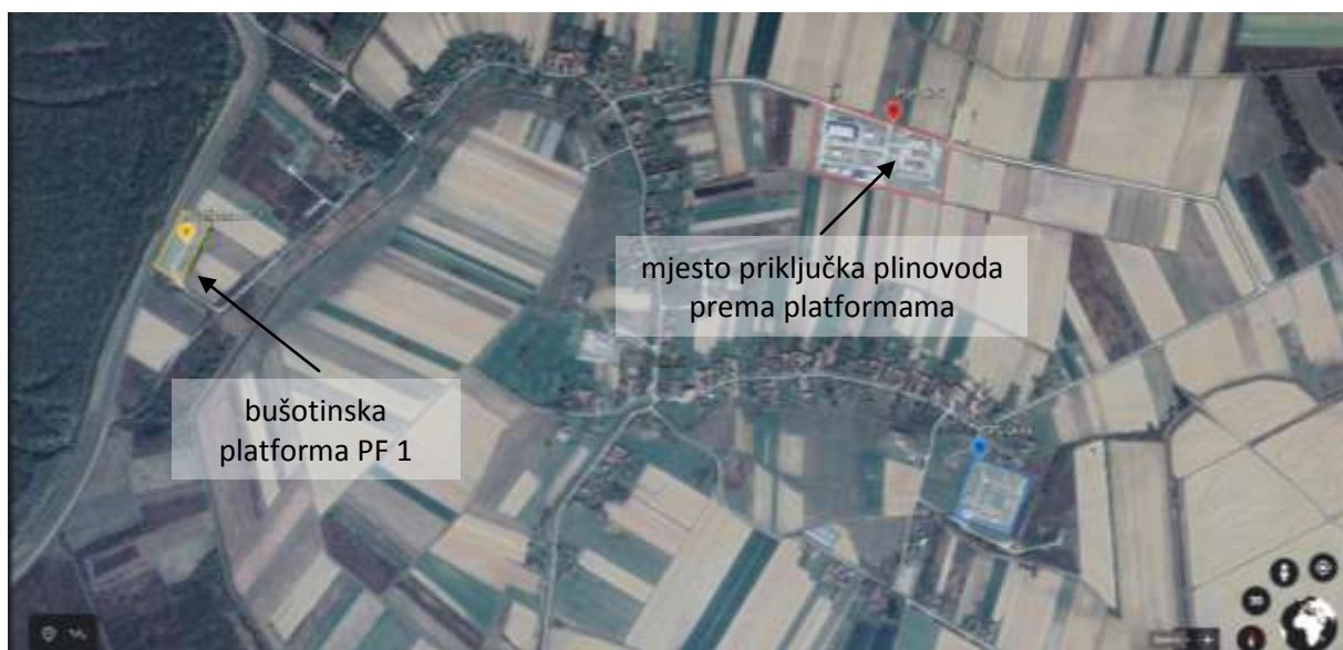
Slika 1. Kritični objekti na području postrojenja Podzemno skladište plina d.o.o. – PSP Okoli
