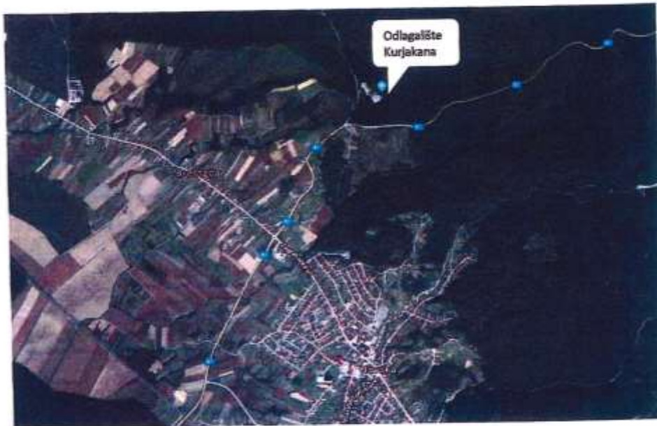
Slika 1. Prikaz makrolokacije odlagališta otpada „Kurjakana“ u odnosu na grad Novska
