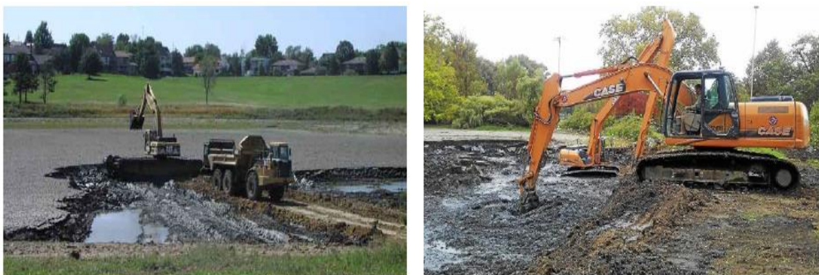
Slika 5. Uklanjanje sedimenta metodom suhozemne mehanizacije
