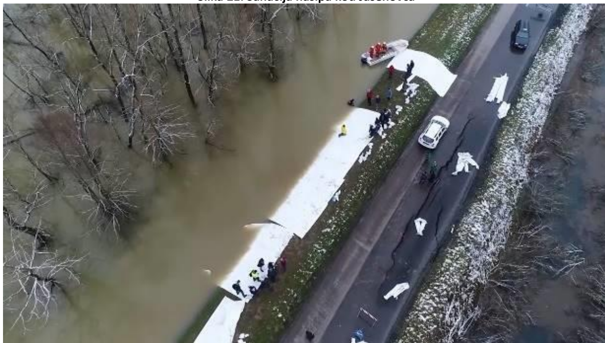
Slika 21. Sanacija nasipa kod Jasenovca
