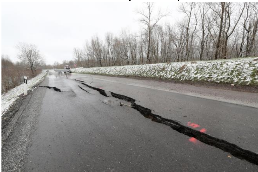
Slika 22. Pucanje ceste uz nasip
