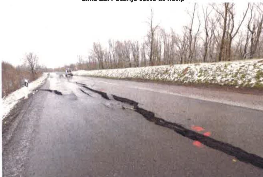
Slika 22. Pucanje ceste uz nasip
