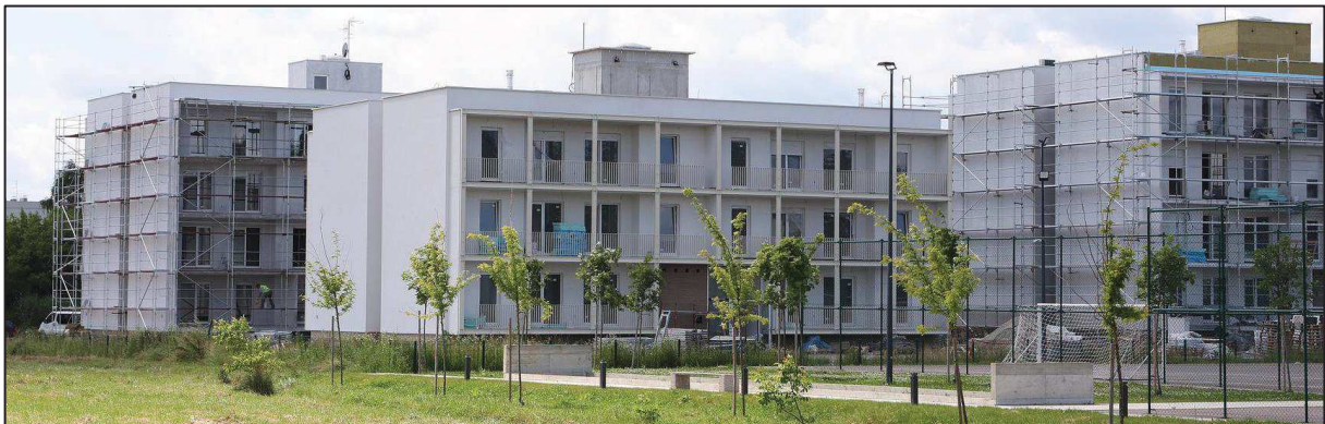
Slika 104. Novoizgrađene višestambene zgrade u Glini u završnoj fazi
