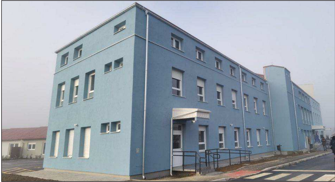
Slika 102. Obnovljen Dom zdravlja u Glini
