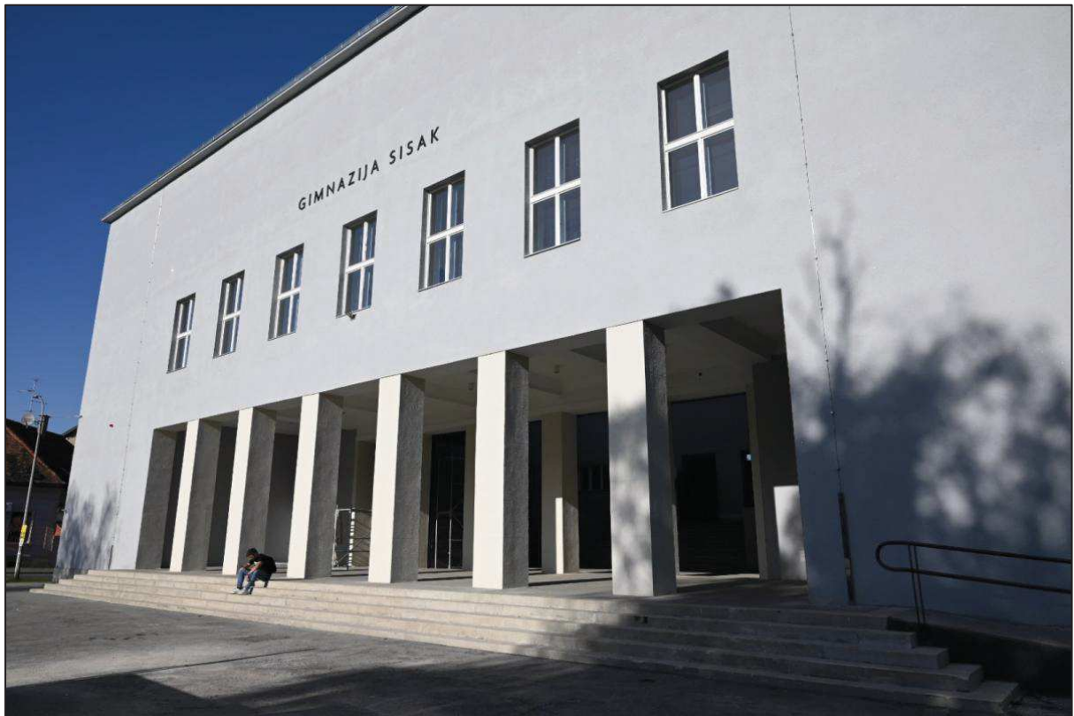
Slika 101. Obnovljena Gimnazija u Sisku
