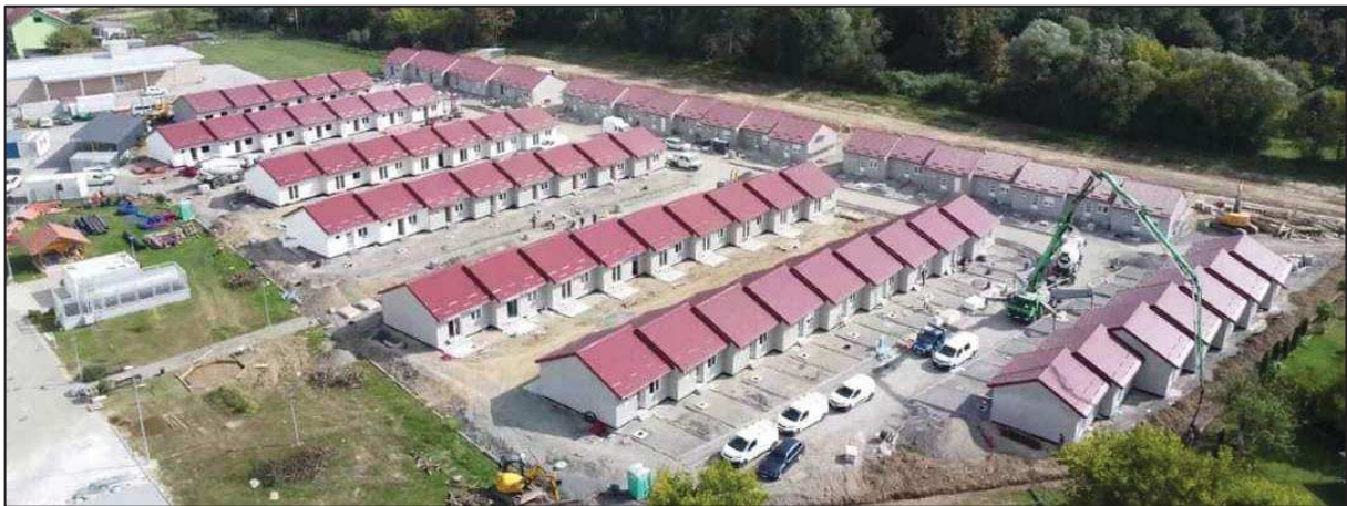
Slika 103. Županijsko naselje „Banovi Dvori „u Glini -u fazi dovršetka
