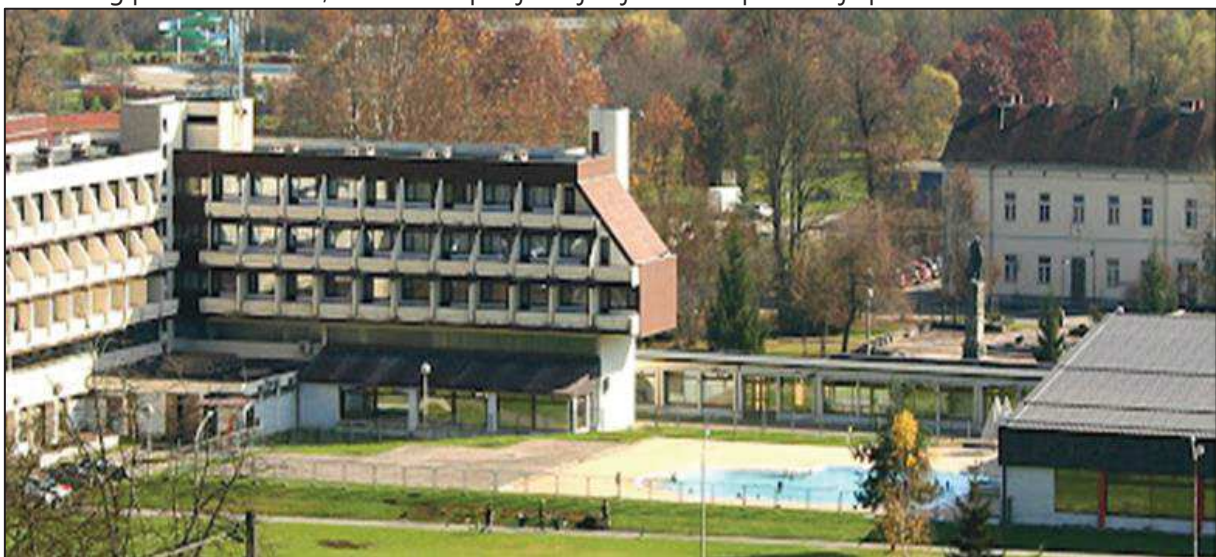
Slika 125. Izgradnja kongresnog centra Topusko
