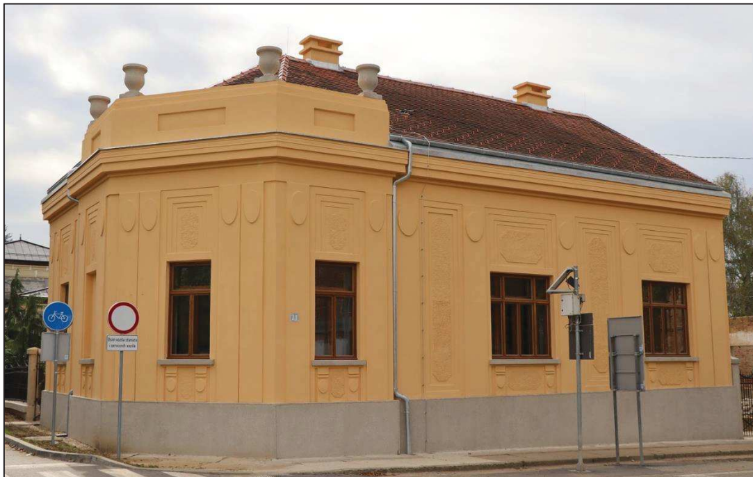
Slika 91. Munjara - pojedinačno zaštićeno kulturno dobro na kojem su završeni radovi cjelovite obnove
