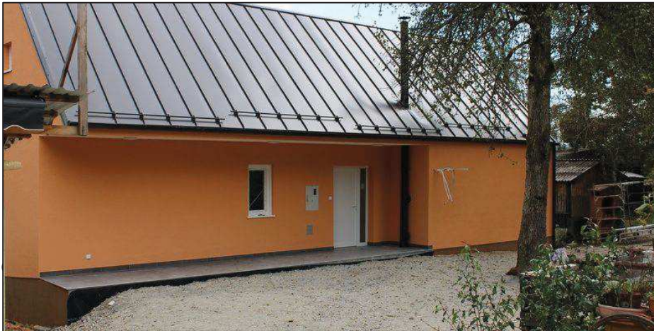
Slika 98. Izgrađena obiteljska kuća u selu Nebojan, Grad Petrinja, Središnji državni ured za obnovu i stambeno zbrinjavanje
