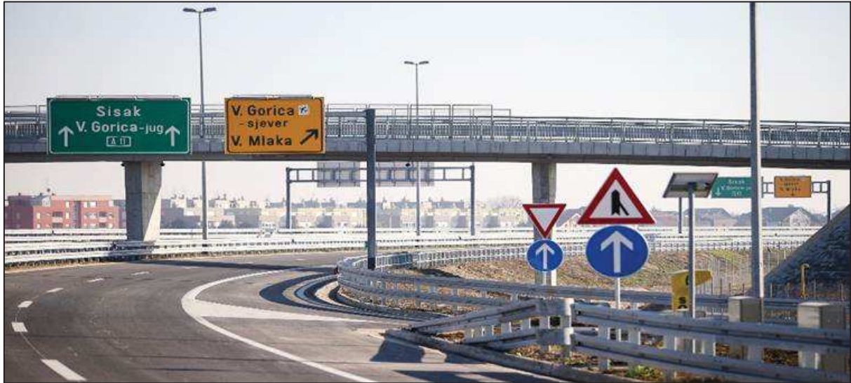
Slika 123. Izgradnja autoceste A11 Zagreb-Sisak
