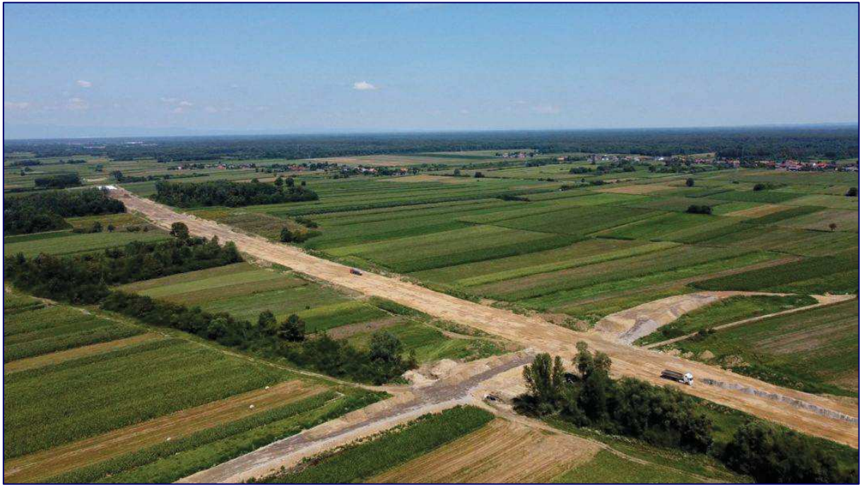
Slika 23. Izgradnja autoceste od čvora Lekenik do Siska, svibanj 2022. Izvor: https://ps-portal.eu/2022/08/03/
